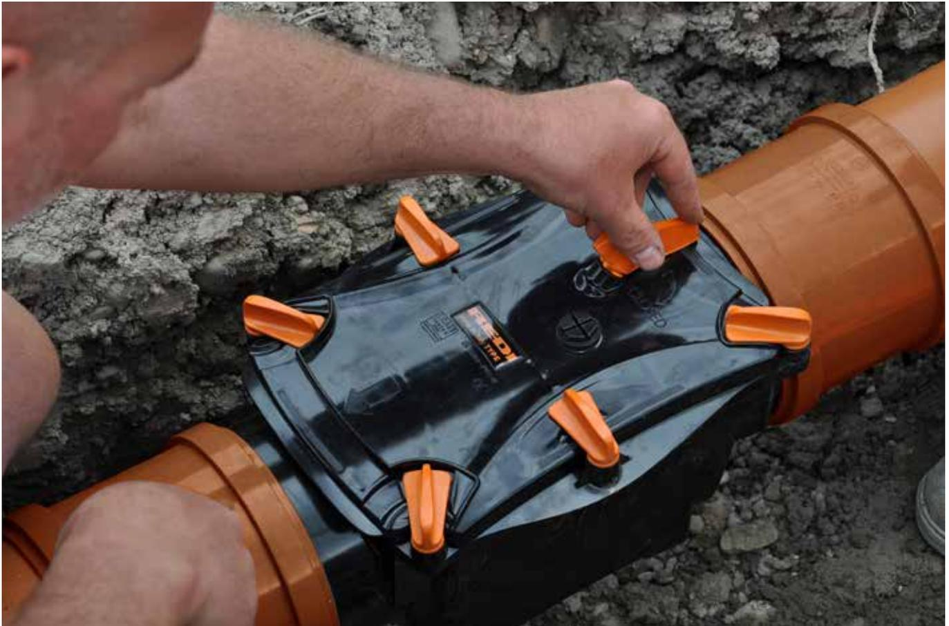
Valvola antiriflusso Ottima installata in pozzetto di ispezione
