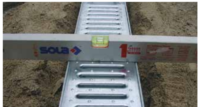
Appoggiare i canali facendo attenzione che il livello della griglia sia quello del suolo
