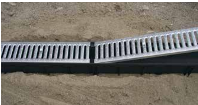
Appoggiare le griglie sui canali La lunghezza delle griglie in metallo è 997 \pm 1 mm per evitare problematiche di dilatazione lineare
