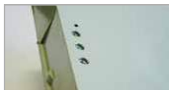
Fori sul fondo per impedire la formazione del ghiaccio
