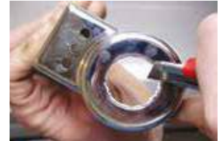
4) adattamento della rosetta cromata (d. 1"1/4 e 1"1/2 prefondato)
