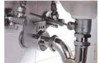
6) montaggio del sifone e armonia estetica finale
