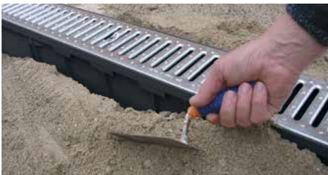
Rincalzare bene con il cemento in modo da non lasciare vuoti d'aria. Fare attenzione che i canali siano posati con le griglie. Un consiglio è di porre dei piccoli spessori tra griglia e bordo del canale in modo da permettere, una volta finito il lavoro, una comoda ispezione togliendo le griglie
