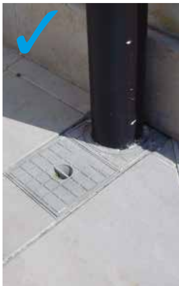
Pozzetto pluviale corretta installazione
