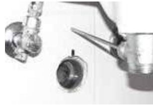
1) smontaggio del sifone esistente
